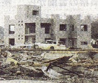
正光さんが建て、津波に耐えた鉄筋コンクリートの宮城県南三陸町の住宅(尾形さん提供)
